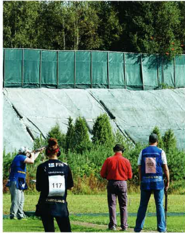
Haulikkoradan vallit on katettu ja vallien päällä on vielä seinämät, jotta haulien leviämisaluetta pienennetään ja haulit saadaan kerätyksi alueelta.
